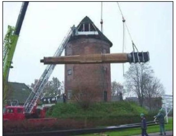
7 t schwere Welle einer Turmmühle
