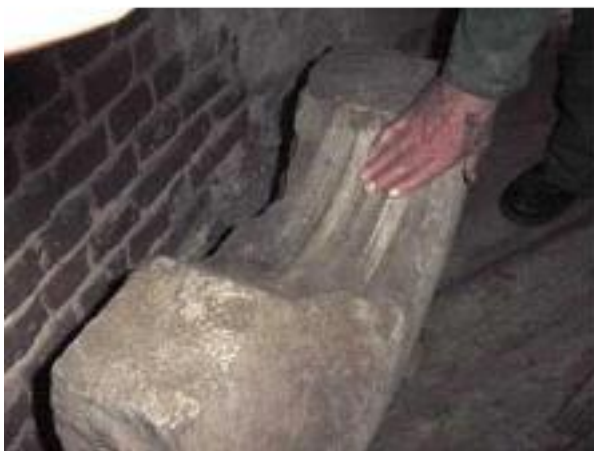
Halslager der Holzwelle
