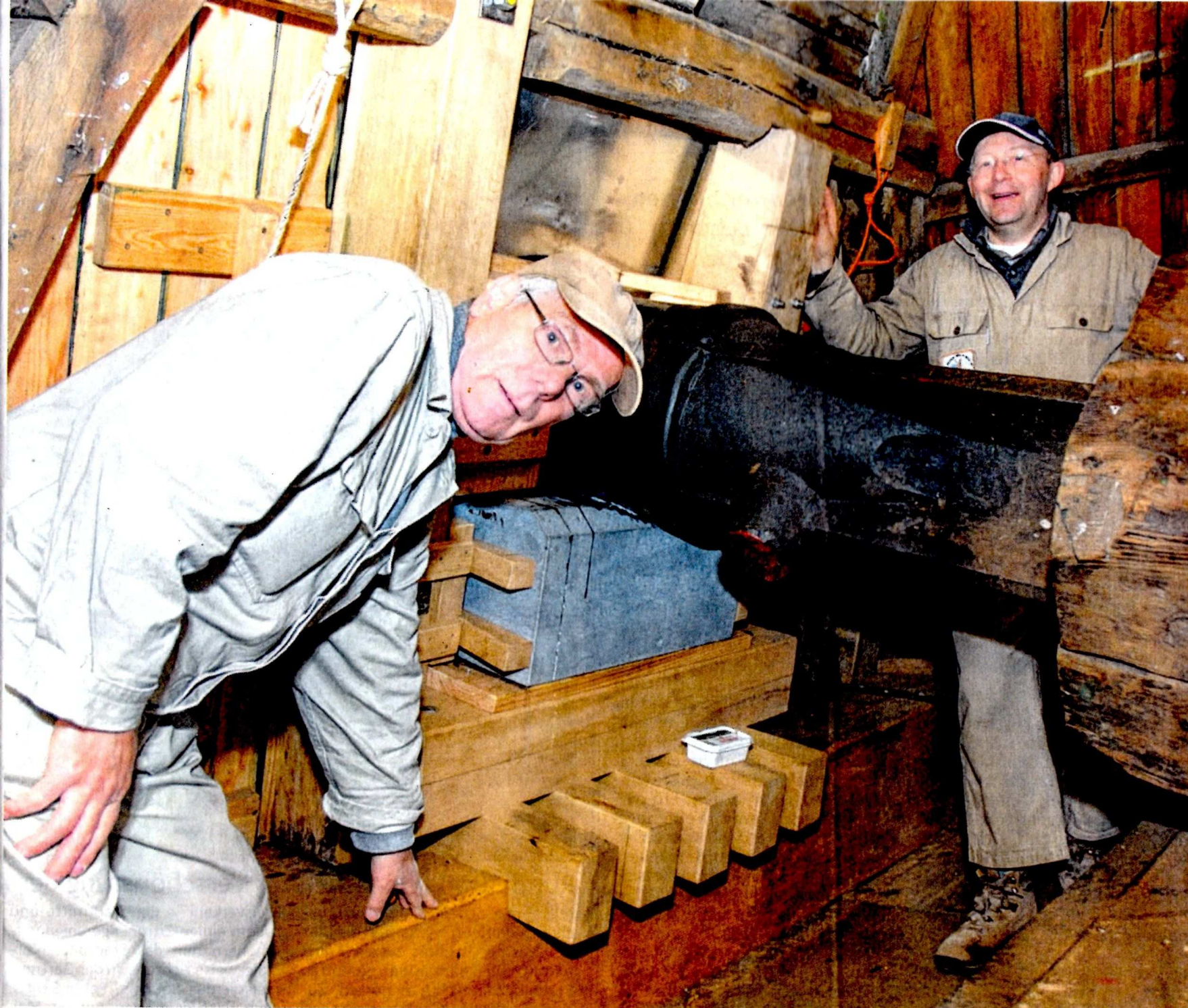
Beim Deutschen Mühlentag in Waldfeucht-Haaren: Willi Reissen (l.) und Hubert Verbeek zeigten den erneuerten Wetterbalken, der die Flügelwelle samt vier Flügeln tragen muss. Foto: Franz Severins
