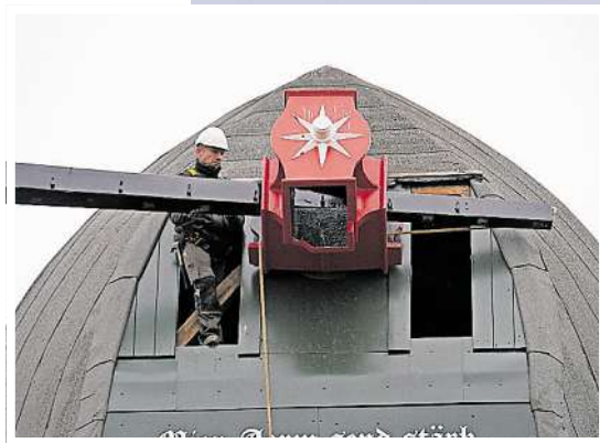
Erneuerte Flügelruten für die Haarener Mühle: Mit einem Spezialkran werden die restaurierten Stahlkolosse an der historischen Windmühle angebracht. Die niederländischen Spezialisten führen die Stahlrute (kleines Bild) in die Mühlenwelle ein.
