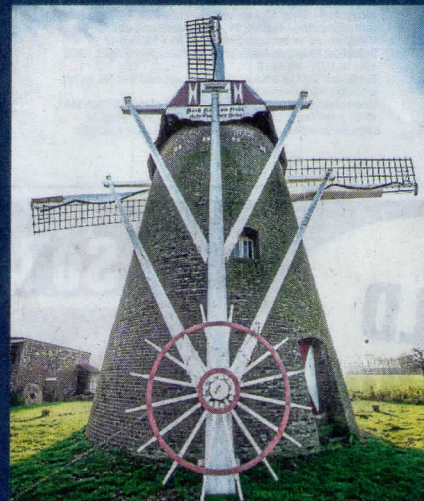
In die Waldfeuchter Windmühle wurde viel Geld investiert
