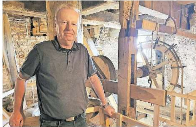
Jede Menge Handlungsbedarf besteht in der Mühle in Waldfeucht aus dem Jahr 1897. Josef Vraetz ist froh darüber, dass das Land NRW 90 Prozent der Kosten für die Sanierung übernimmt.
